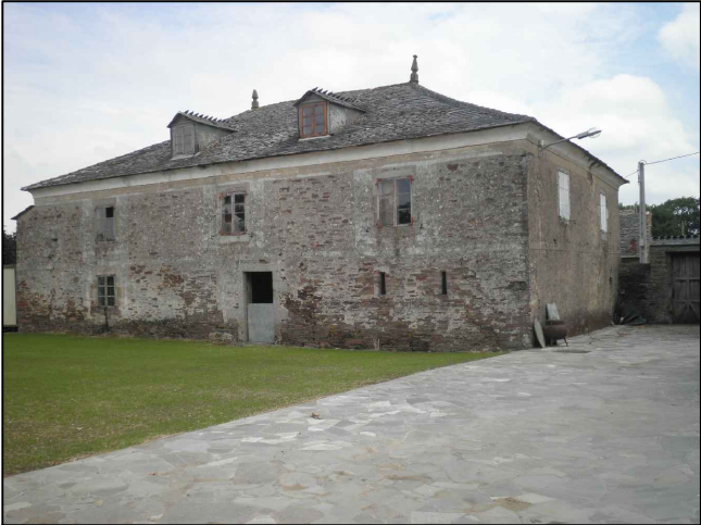
Casa Fachada Posterior
